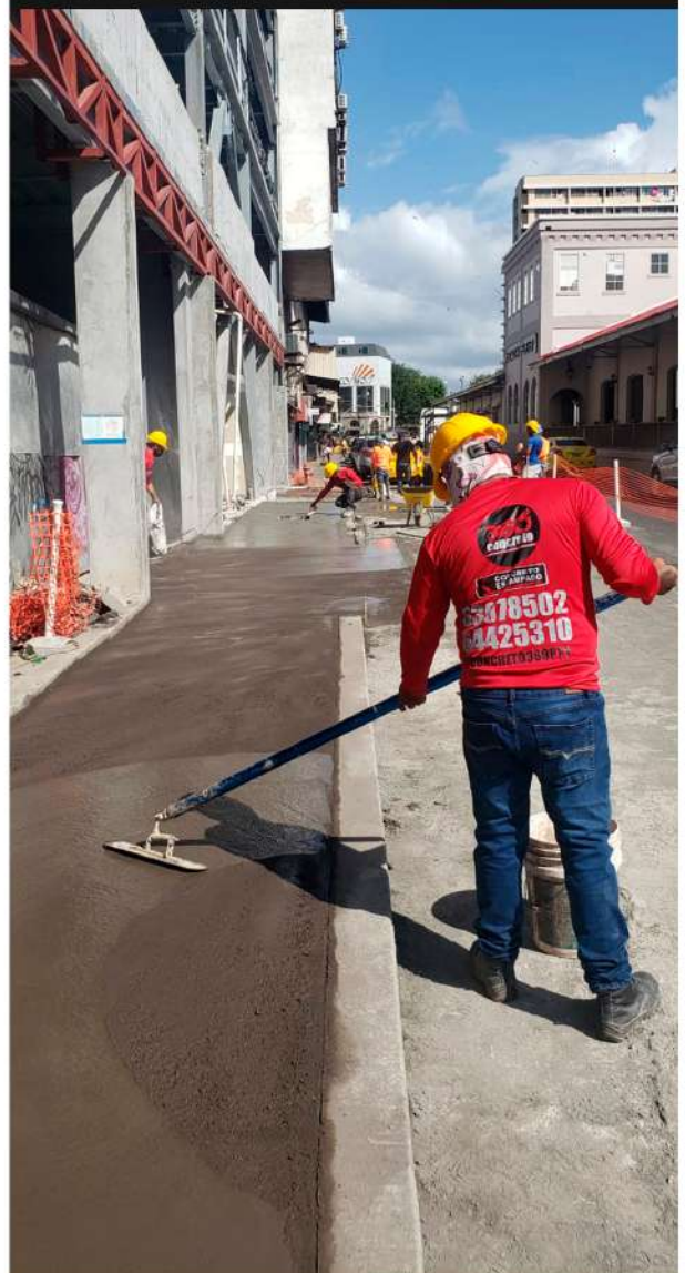
Aplicación de ConcretColors a la losa de concreto
