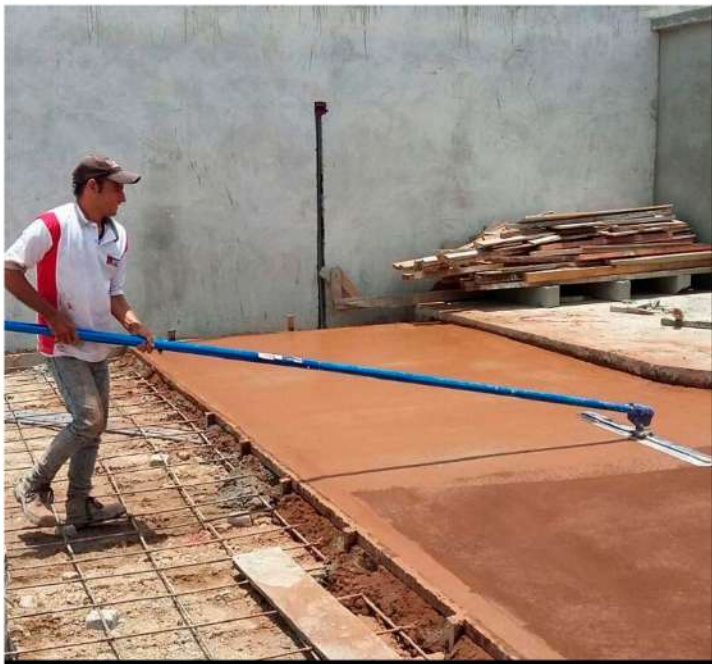
Aplicación de ConcretColors a la losa de concreto
